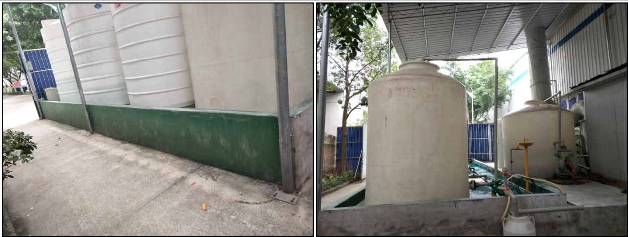
稀硫酸储存区
