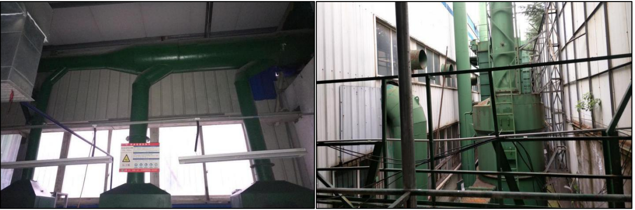
废气处理措施
