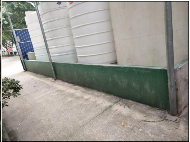
稀硫酸储存区
